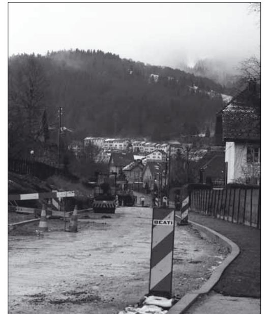
Le trottoir à la rue des Rosiers.
